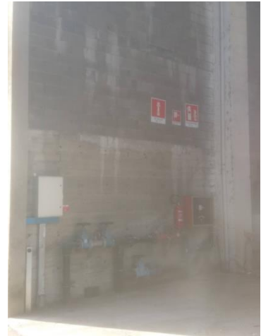
Figura 2- Attacco Motopompa per VVF
