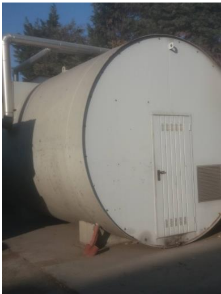
Figura 3- Riserva idrica con gruppo motopompa
